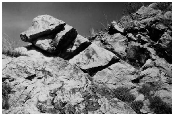
Εικ. 7. Συστήματα ασυνεχειών που αποκόπτουν τεμάχια με πλευρές που σχηματίζουν αμβλεία γωνία. Τέτοια τεμάχια έχουν χρησιμοποιηθεί για τις οροφές των στοών.
