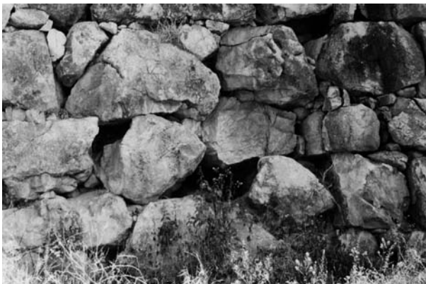
Εικ. 4. Λεπτομέρεια δομής οχυρωματικού τείχους όπου σε ορισμένες θέσεις φαίνονται οι περιορισμένες επιφάνειες επαφής των ογκολίθων.
