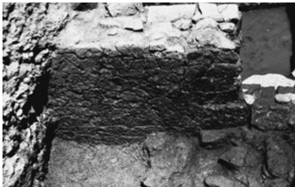
Εικ. 46. Νότιο άκρο τ. Μ, εσωτερική όψη.
