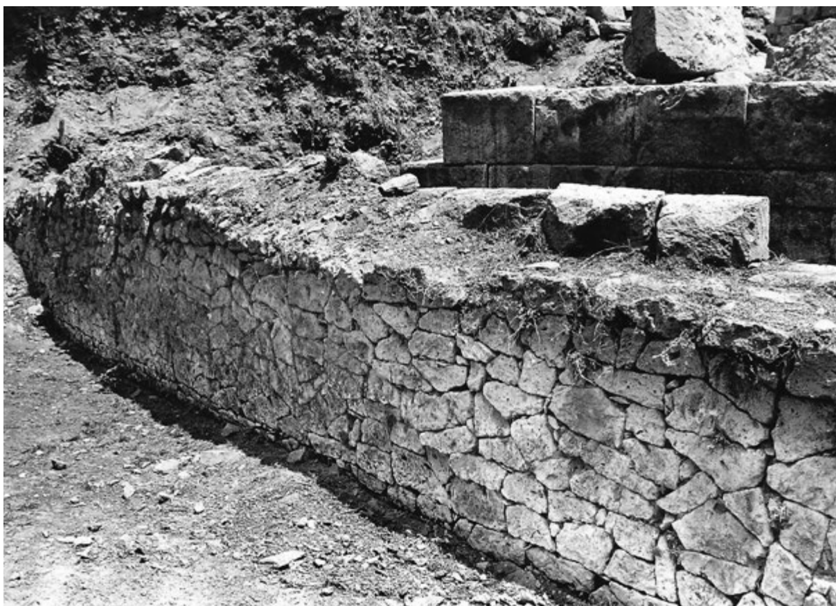
Εικ. 45. Τοίχος Μ, εσωτερική όψη.
