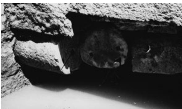
Εικ. 8. Δεξαμενή-Φρέαρ Α, λεπτομέρεια της κατασκευής.
