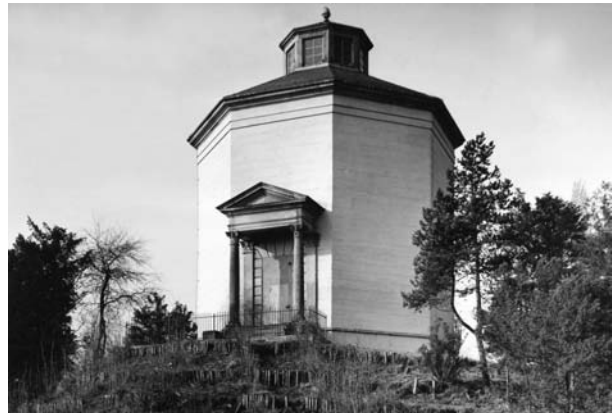
Abb. 8. Turm der acht Winde am Mildensee im Dessau-Wörlitzer Gartenreich.
