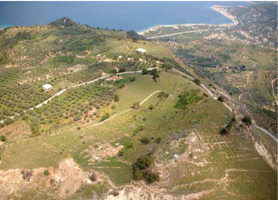
Εικόνα 16. Η εγκατάσταση της ακρόπολης της Αιγείρας.
