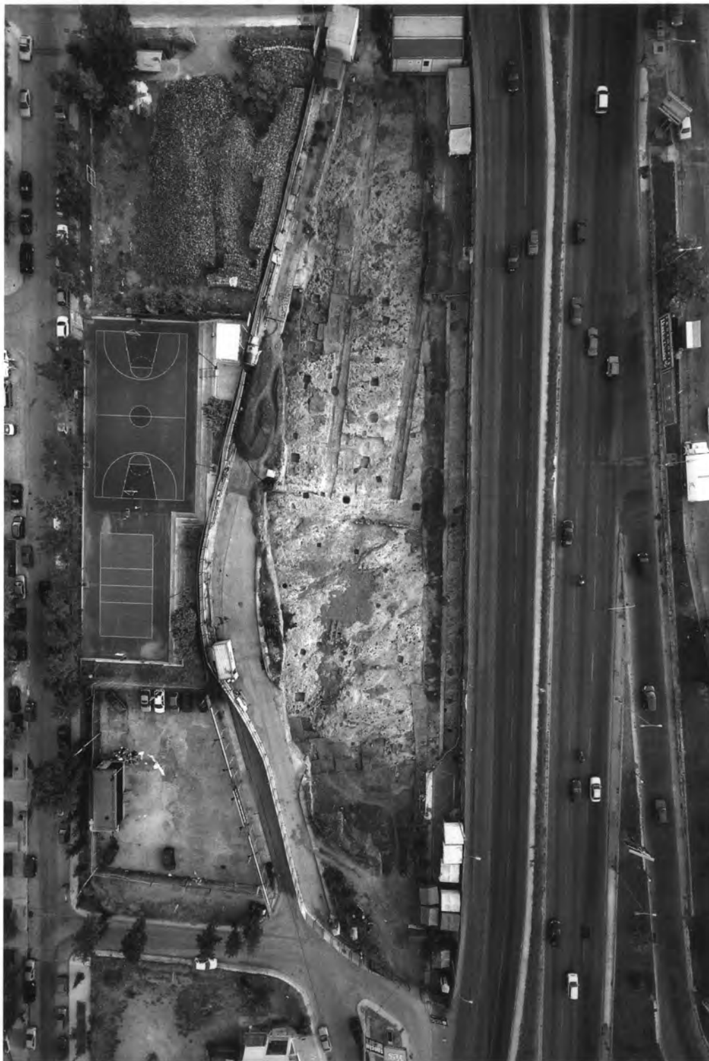
Εικ. 2. Κοντοπήγαδο. Αεροφωτογραφία της εργαστηριακής εγκατάστασης, όπου φαίνονται οι δύο εκ των τεσσάρων άγωγών.
