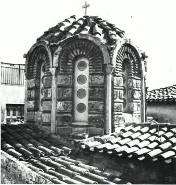
Είκ. 3. Ἁγ. Ἰωάννης Θεολόγος. Ὁ τροῦλλος μετὰ τὰς ἐργασίας.
