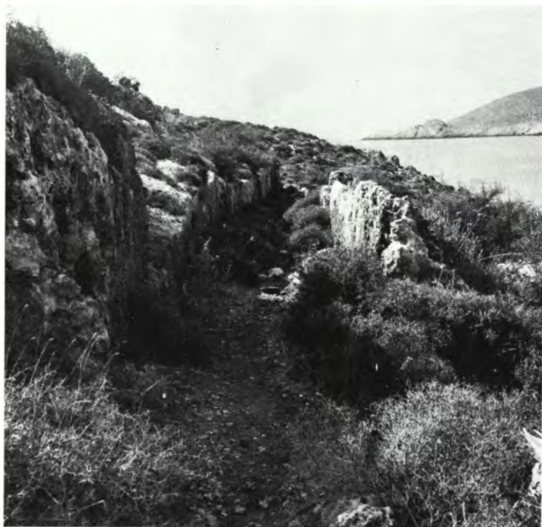
Εικ. 5. Τμήμα του δρόμου-διώρυγας. Ἀποψη ἀπὸ Β.
