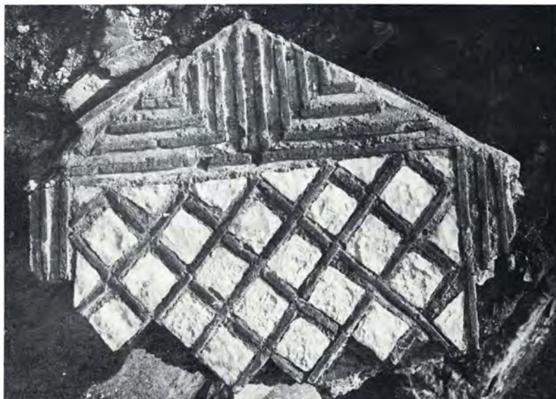
Είκ. 9. Τμήμα τοιχοποιίας της Ν. στοάς
