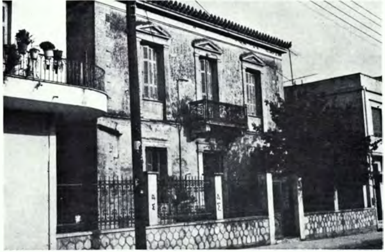
Είκ. 20. Ἀρχοντικό Καλλιάρχη — ἄποψη ἀπὸ τὴν ὁδὸ Δαναοῦ ( ΒΔ ).
