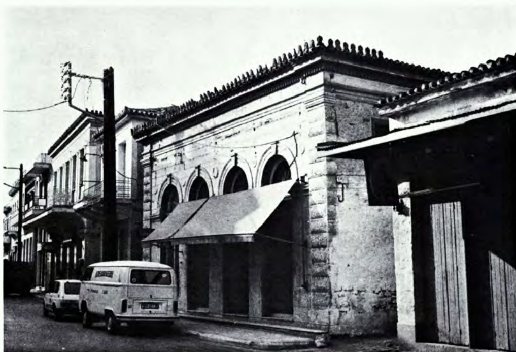
Είκ. 23. Κατάστημα Ήλίας Κωνσταντόπουλου — ἄποψη ἀπὸ τὴν ὁδὸ Τσώκρη ( ΝΑ. ).
