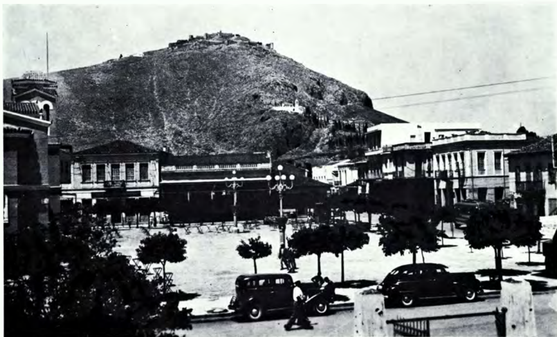
Είκ. 32. Μέρος της πλατείας τοῦ Ἀγ. Πέτρου, ἀπὸ ταχυδρομικὸ δελτάριο τοῦ 1955(:). Στὸ κέντρο φαίνεται τὸ ἀρχοντικὸ Μυστακόπουλου, τὸ καφενεῖο « τοῦ Θηβαίου » καὶ ὁ « Γυαλί-καφενές ». Στὸ δεξιὸ μέρος τῆς φωτογραφίας τὸ οἶκημα ὅπου τότε τὸ ξενοδοχεῖο « Βύρων » ( δεῦτερο ἀπὸ δεξιὰ· πρῶτο ἀπὸ δεξιὰ τὸ σπίτι τῆς ἱστορικῆς οἰκογένειας Ρούσσου, πού κατεδαφίστηκε πρόσφατα ).
