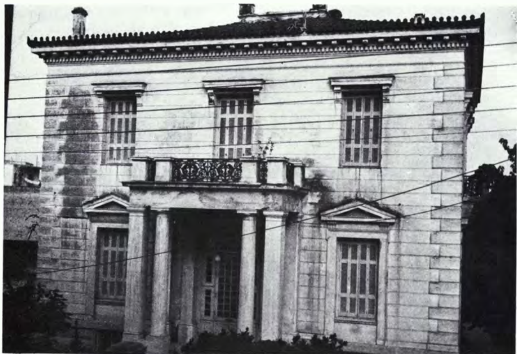
Εικ. 29. 'Αρχοντικό 'Ηλία Κωνσταντόπουλου — ή πρόσοψη του κτιρίου από την οδό Δαναού (ΝΔ).
