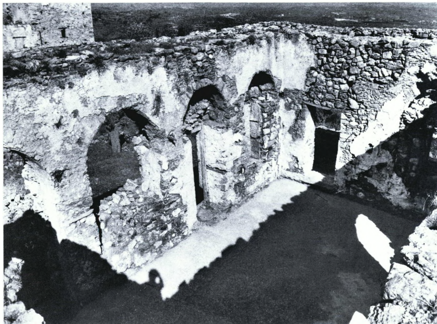
Εικ. 7. Τρίκλινος. Εσωτερική άποψη προς ΒΑ. με τις επεμβάσεις στα ανοίγματα προς τον εξώστη και τα αψιδώματα της περιόδου της Τουρκοκρατίας.
