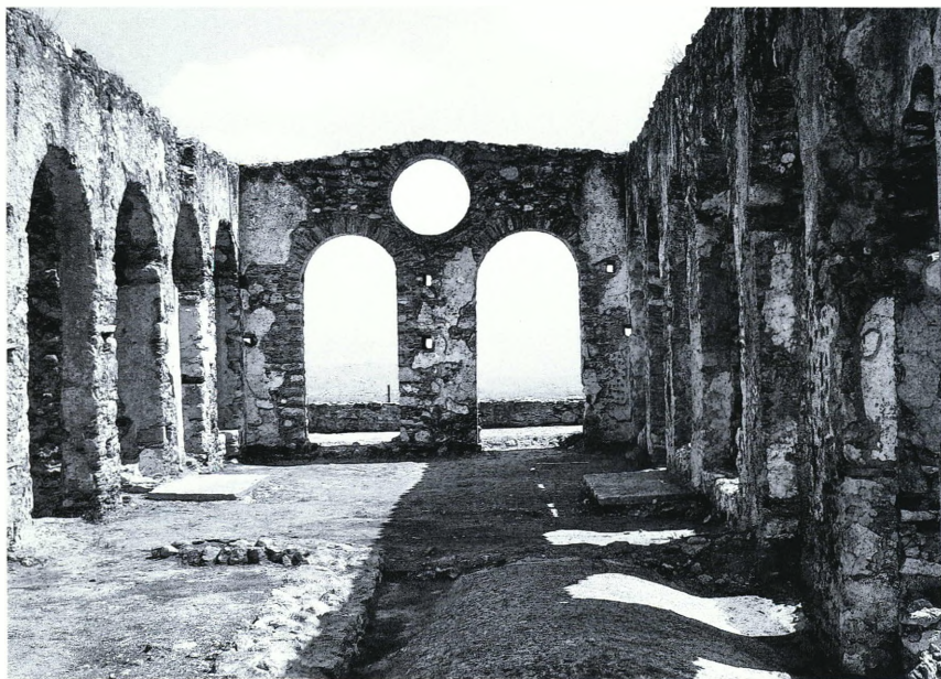
Εικ. 8. Τρίκλινος. Εσωτερική άποψη προς Α. μετά την αποκατάσταση των αρχικών ανοιγμάτων προς τον εξώστη και την καθαίρεση της μεταγενέστερης τοιχοποιίας στα αψιδώματα.
