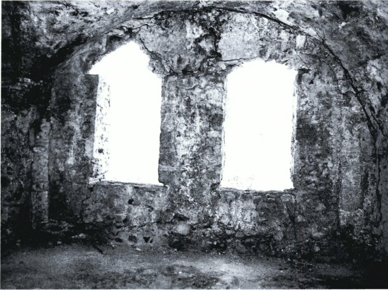
Εικ. 14. Βόρειος χώρος της β' στάθμης. Εσωτερική άποψη προς Α. πριν από την καθαίρεση του διαφράγματος του τόξου της περιόδου της Τουρκοκρατίας.
