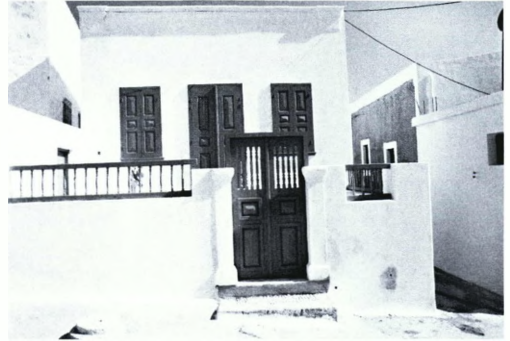
Εικ. 3. Το κτίριο μετά τις εργασίες αποκατάστασης.
