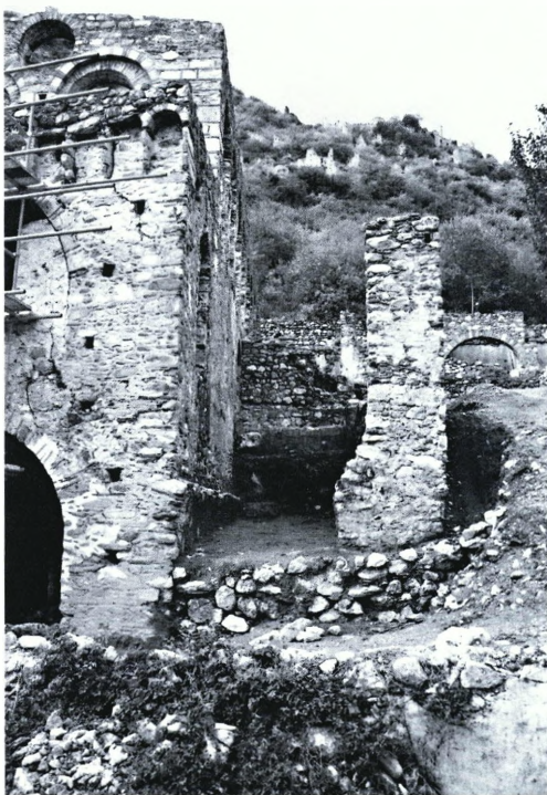
Εικ. 18. Βόρεια στοά της οικίας Λάσκαρη μετά τους καθαρισμούς. Ανατολική όψη.
