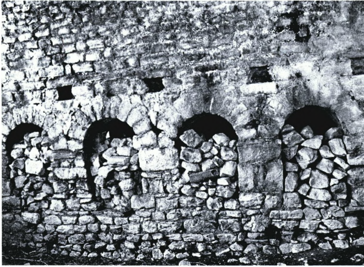
Εικ. 17. Θέση Θόλοι. Πέμπτος θόλος (τοξωτά ανοίγματα και δοκοθήκες).
