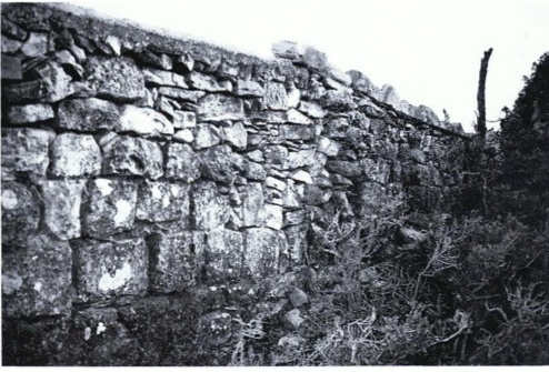
Εικ. 2. Θέση Άγιος Κωνσταντίνος. Οικοδομικά λείψανα οχυρωματικής κατασκευής.
