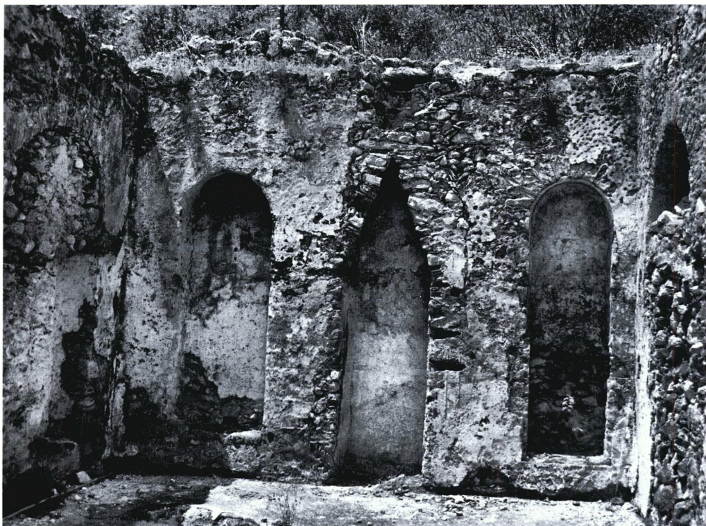
Εικ. 9. Τρίκλιнос. Άποψη προς Δ., τρίκογχη διαμόρφωση με τη μετατροπή σε τζάκι της μεσαίας κόγχης κατά την περίοδο της Τουρκοκρατίας.
