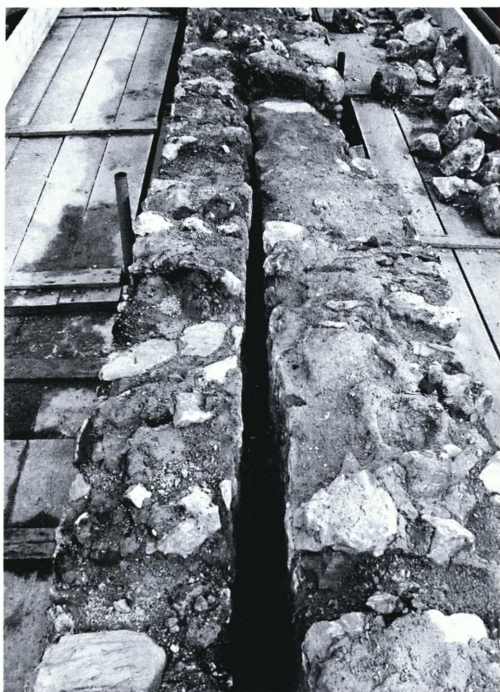
Εικ. 6. Τρίκλιнос. Λεπτομέρεια κατασκευής του νότιου τοίχου κατά την επαφή του με τον αρχικό πυρήνα της οικίας.
