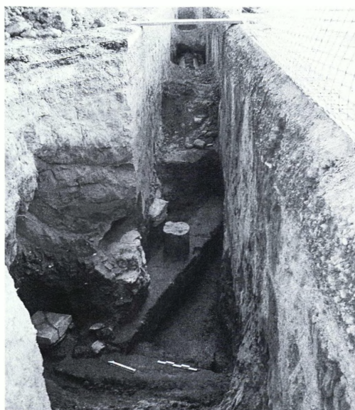
Εικ. 3. Οι αποκαλυφθέντες τοίχοι μετά τη διάνοιξη του δρόμου για την τοποθέτηση του αγωγού ύδρευσης.
