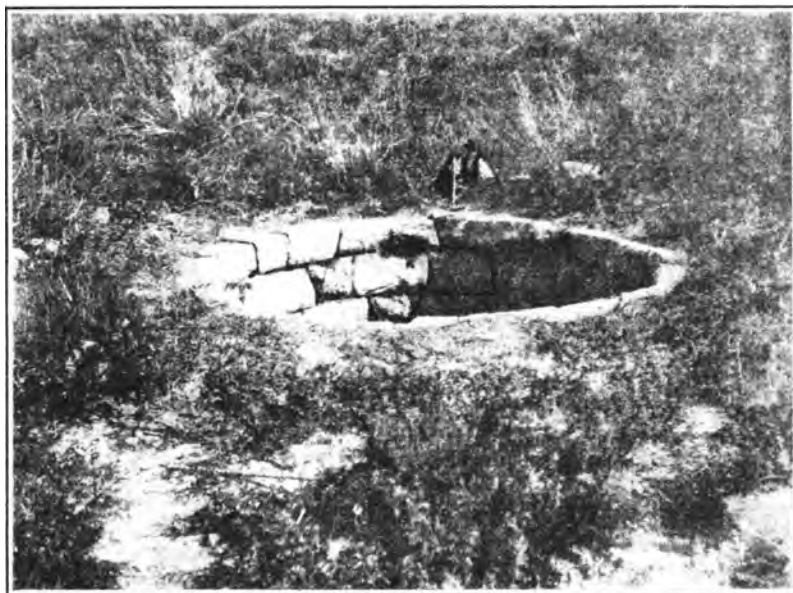
Εἰκ. 3. Ἡ κυκλικὴ δεξαμενὴ.
