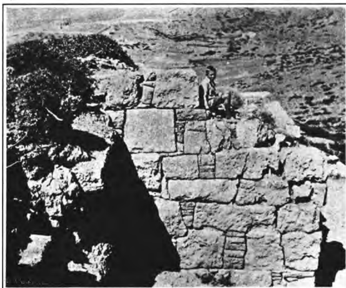
Εἰκ. 45. Τοῖχος πύργου τοῦ φρουρίου Σουνίου.
