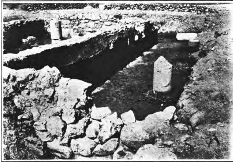
Εἰκ. 24. Βορεία πλευρὰ σηκοῦ μετ' κίονας περιστάσεως.
