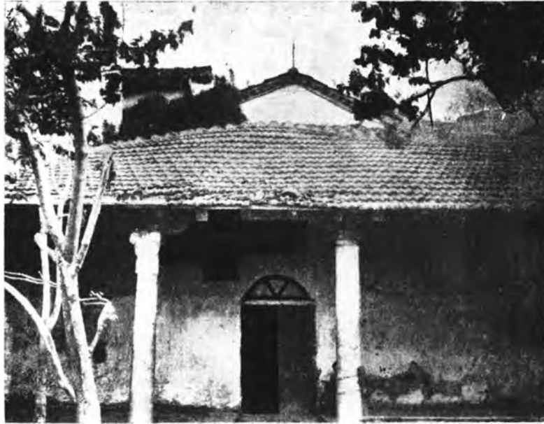
Εἰκ. 6. Νοτία πλευρά.
