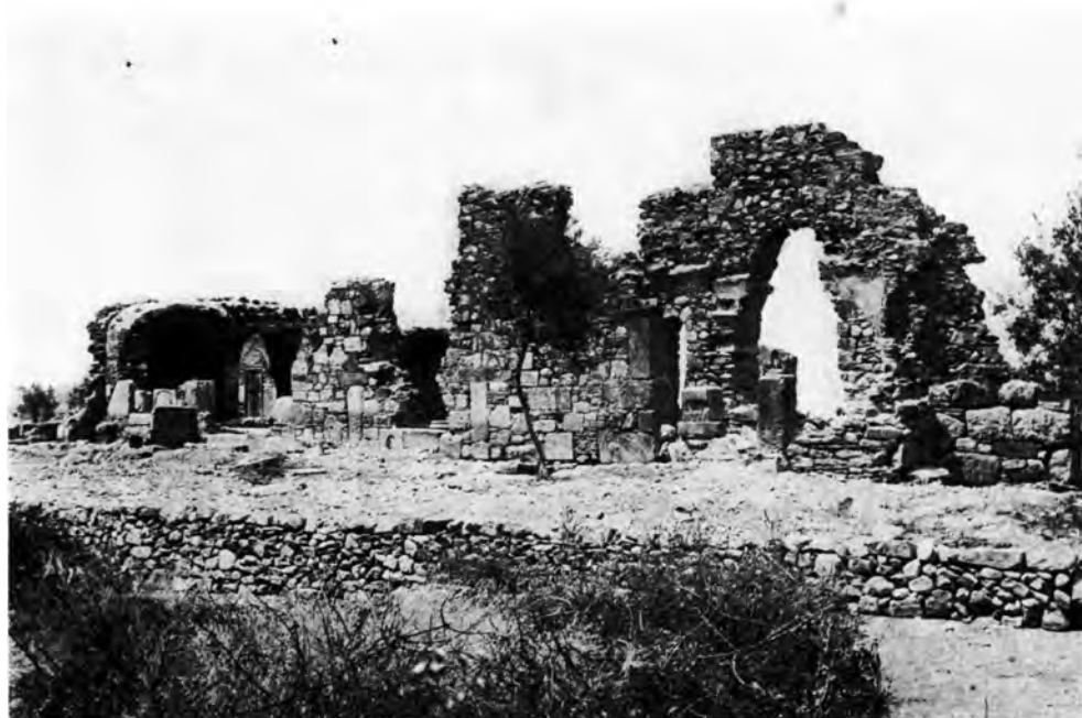
Τροιζήν-Δαμαλάς. Τὰ ἔρειπια τῆς Ἐπισκοπῆς: α. πρὸ τοῦ καθαρισμοῦ, β. μετὰ τὸν καθαρισμὸν
