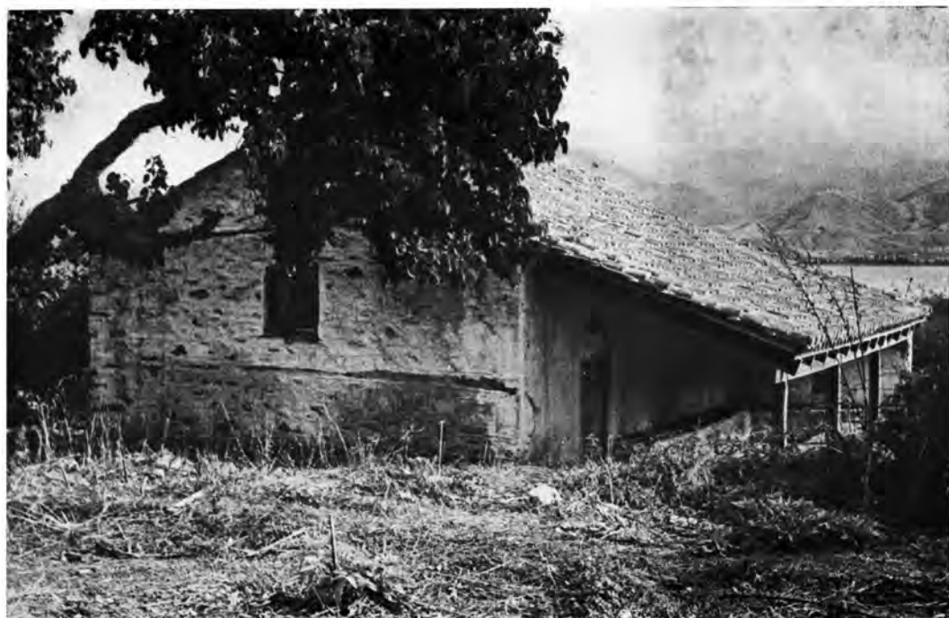
Πρέσπα: α. Ό ναός της Παναγίας Πορφύρας μετά την αποκατάστασιν της στέγης, β. Ό ναός του Άγιου Γεωργίου μετά την αποκατάστασιν της στέγης
