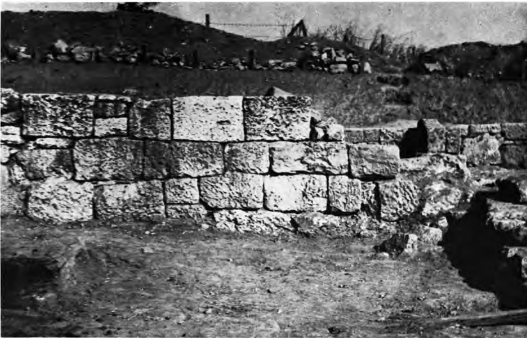
Πέλλα. Τομεύς Ι, τετράγωνον 2: α. Βορειοανατολική περιοχή, β. Τοιχοδομία του μεταξύ των δωματίων Μ και Ν μεσοτόχου. Όψις από δυσμών
