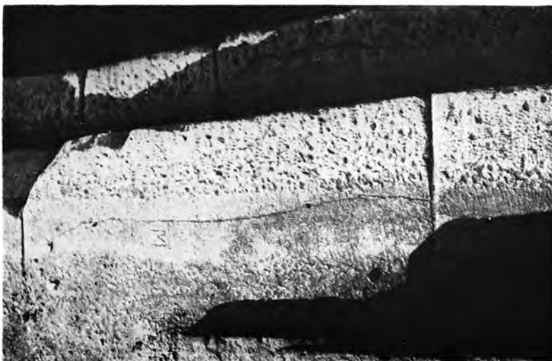
Φίλιπποι: α. Μακεδονικός τάφος Φιλίππων. Ἐξωτερικὴ ὄψις τμήματος τῆς καμαρωτῆς στέγης, β. Τμήμα τοῦ περιβάλλοντος τὸν μακεδονικὸν τάφον τοίχου, γ. Λεπτομέρεια τοῦ κρηπιδώματος Δ. ΛΑΖΑΡΙΔΗΣ
