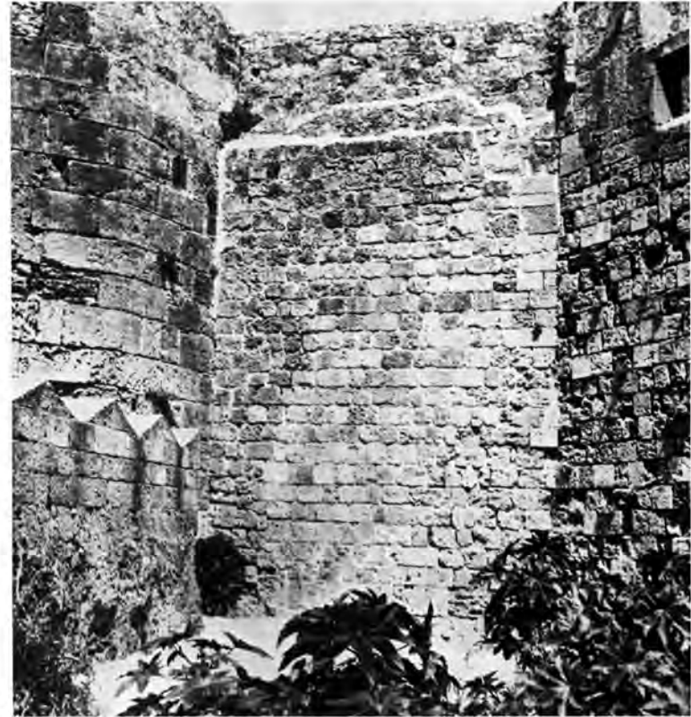
Ρόδος: α - β. Τὸ ρήγμα εἰς τὸν νοτιοδυτικὸν τοῖχον τοῦ πύργου τοῦ Ἁγ. Πέτρου πρὸ καὶ μετὰ τὴν ἔμφραξίν του
