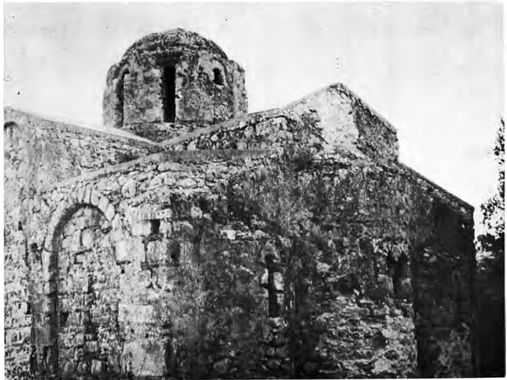
Κρήτη. Στύλος Ἀποκορώνου. Ναὸς Παναγίας: α. Νοτιοδυτικὴ ὄψις πρὸ τῶν ἐργασιῶν ἀναστηλώσεως, β. Νοτιοανατολικὴ ὄψις μετὰ τὰς ἐργασίας ἀναστηλώσεως
