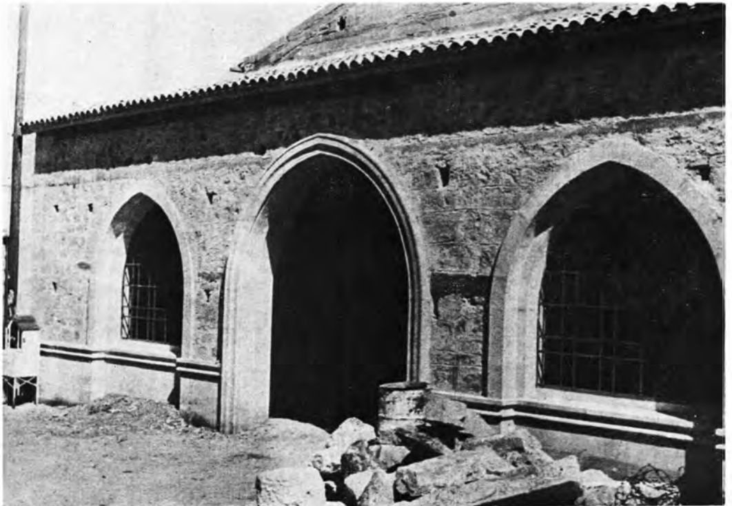
Κρήτη: α. Μπιζαριανώ Πεδιάδος. Ναός Ἁγίου Παντελεήμονος. Νοτία ὄψις πρὸ τῶν ἐργασιῶν ἀποκαταστάσεως, β. Ἡράκλειον. Παναγία τῶν Σταυροφόρων. Δυτική ὄψις προστώου
