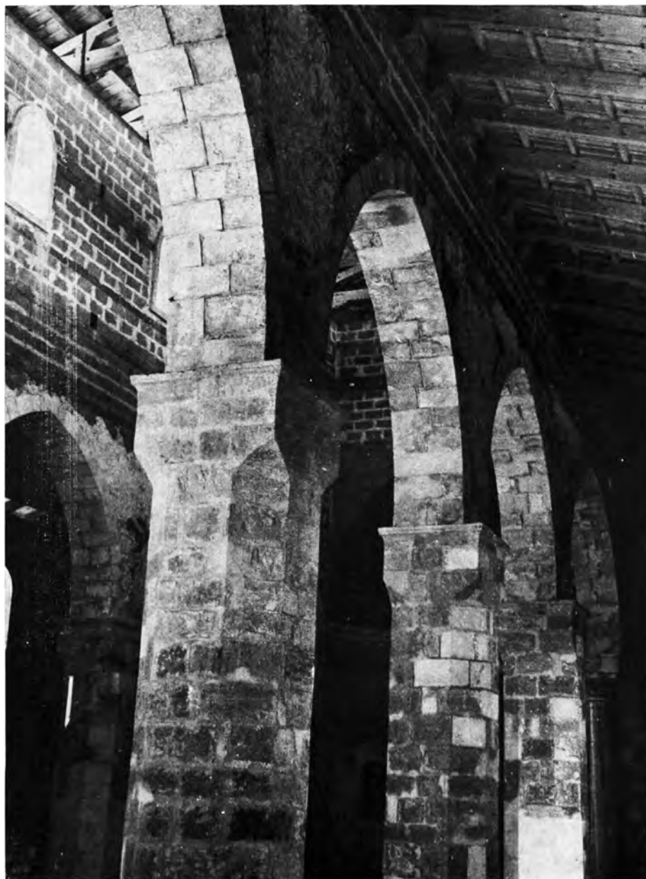
Κρήτη. Ἡράκλειον: Παναγία τῶν Σταυροφόρων. Ἡ ἐσωτερικὴ τοξοστοιχία μετὰ τὴν ἀποκατάστασιν
