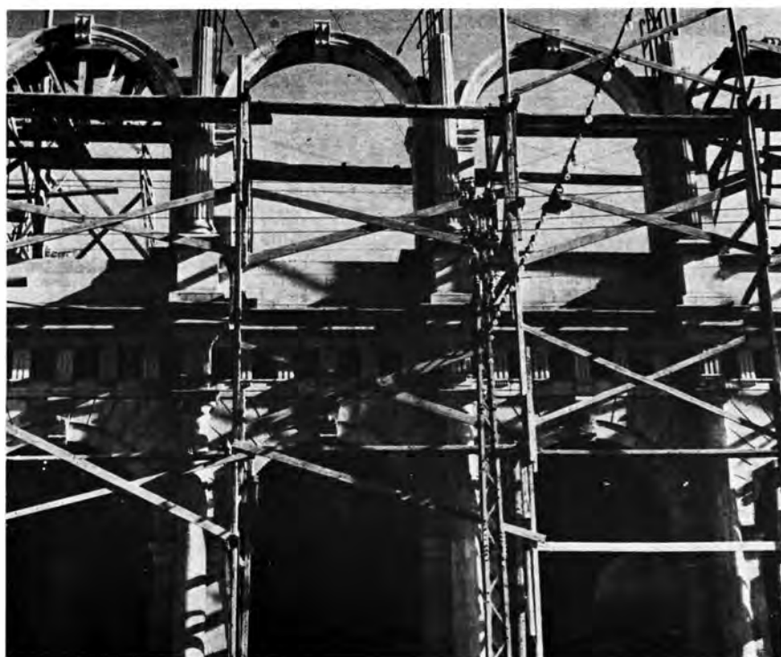
Κρήτη: α. Έτιά Σητείας. Τμήμα τοῦ ἄνω ὀρόφου ἐπαύλεως τῶν Mezzo μετὰ τὸν καθαρισμὸν καὶ τὴν συμπλήρωσιν τοῦ πλακοστρώτου δαπέδου, β. Ἡράκλειον. Ἐνετικὴ Λέσχη. Τμήμα δυτικῆς ὀψεως
