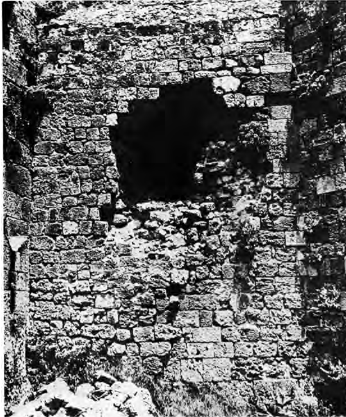
Ρόδος: α - β. Τὸ ρήγμα εἰς τὸν νοτιοδυτικὸν τοῖχον τοῦ πύργου τοῦ Ἁγ. Πέτρου πρὸ καὶ μετὰ τὴν ἔμφραξίν του
