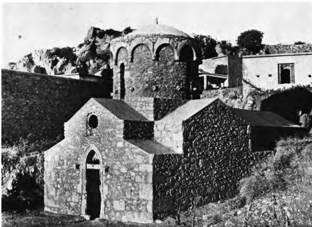
Κρήτη. Άξός Μυλοποτάμου. Ναός Ἁγίας Εἰρήνης: α. Ἐσωτερική ὄψις νοτιοδυτικῆς γωνίας πρὸ τῶν ἐργασιῶν ἀναστηλώσεως, β. Ὁ ναὸς μετὰ τὴν ἀποκατάστασιν
