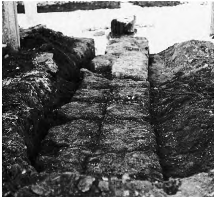
Θήβαι : α. Οικόπ. Λαλιώτη. Βυζαντινοί τοίχοι, β. Οικόπ. Λαλιώτη. Μυκηναϊκὸν κτήριο, γ. Οικόπ. Δ. Ἄδριανου εἰς Ἁγίους Θεοδώρους. Τοῖχος κλασσικῶν χρόνων
