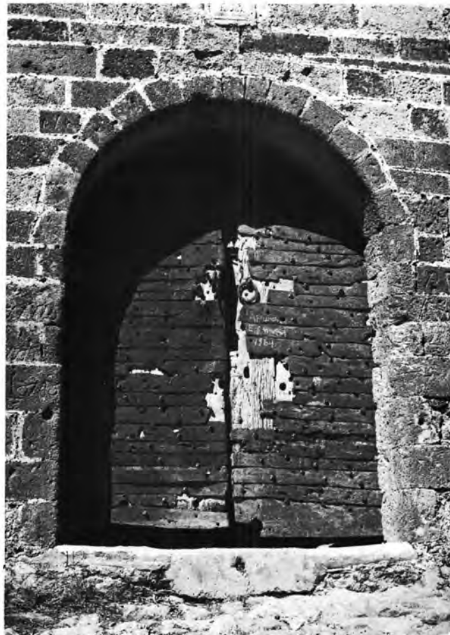
Μονεμβασία: α. Άνω φρούριον. Ή πύλη, β. Λεπτομέρεια του πύργου εισόδου του κάτω φρουρίου μετά τας ἐργασίας
