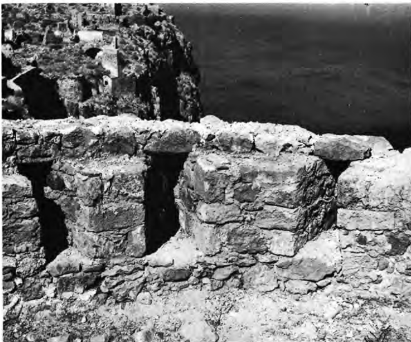
Μονεμβασία : α-δ. Τὸ ἄνω φρούριον πρὸ καὶ κατὰ τὰς ἐργασίας
