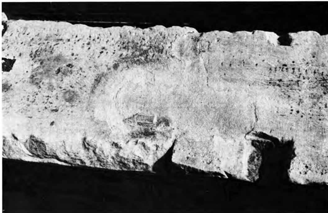
Ἄθῆναι : α - β. Τμήμα τῆς ἐπικρανίτιδος τῆς Ν. πλευρᾶς τοῦ Ἐρεχθείου πρὸ καὶ μετὰ τὴν ἀντικατάστασιν τοῦ ὀξειδωμένου συνδέσμου
