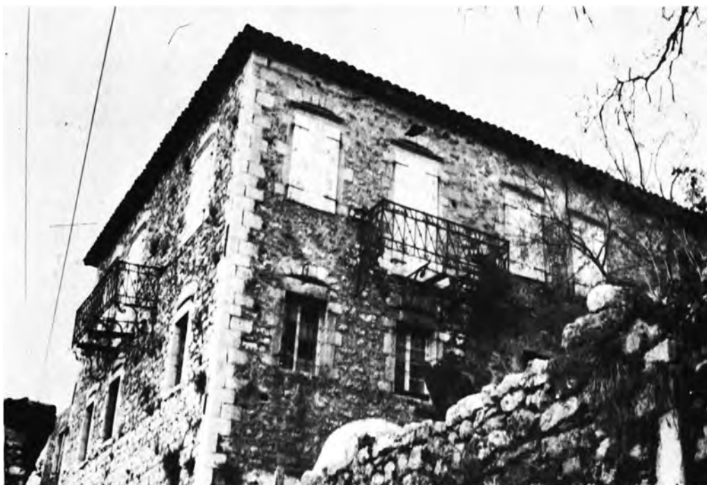
Δημητσάνα. Οικία πρώην Ἀντωνοπούλου : α. Λεπτομέρεια τῆς ξυλογλύπτου ὀροφῆς, β. Ἡ οἰκία μετὰ τὰς ἐργασίας
