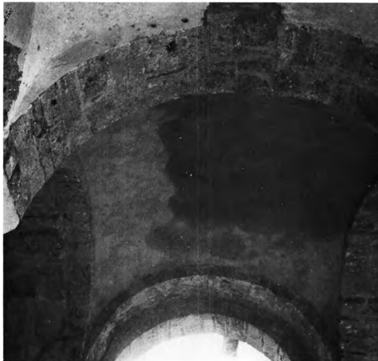
Μυστράς. Μητρόπολις : α. Ή Δ. θύρα μετά τὰς ἐργασίας, β. Φουρνικὸν ΒΔ. γωνίας μετά τὰς ἐργασίας
