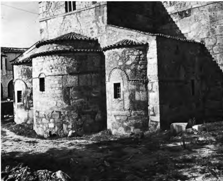
Όρχομενός, Μονή Σκριπούς : α. Άποκαλυφθέντα λείψανα κλίμακος, β. Ή Α. πλευρά του ναού πρό της κατασκευής του λιθοστρώτου
