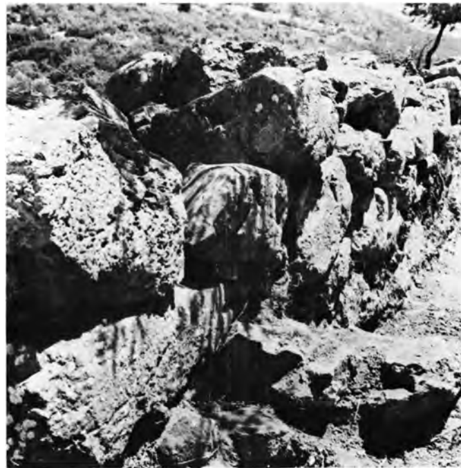
Φοινίκιον Λακωνίας. Ἱερὸν Ὑπερτελεάτα Ἀπόλλωνος : α. Τμήμα τῆς Δ. πλευρᾶς πρὸ τοῦ καθαρισμοῦ, β. Τμήμα τῆς Ν. πλευρᾶς μετὰ τὴν ἀνασκαφὴν
