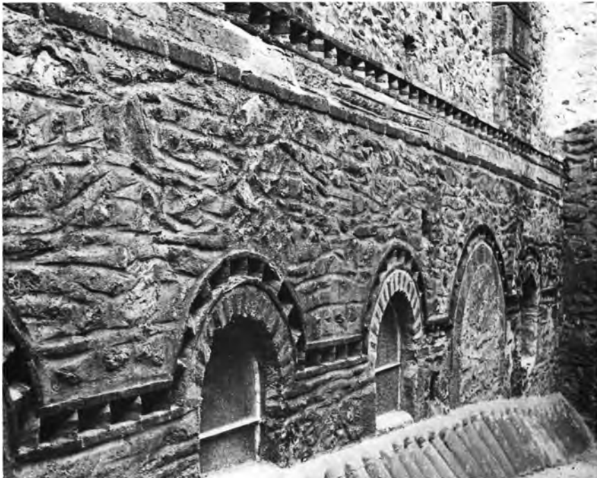
Μυστρᾶς, Μητρόπολις : α - β. Ἡ Ν. πλευρά μετὰ τὰς ἐργασίας
