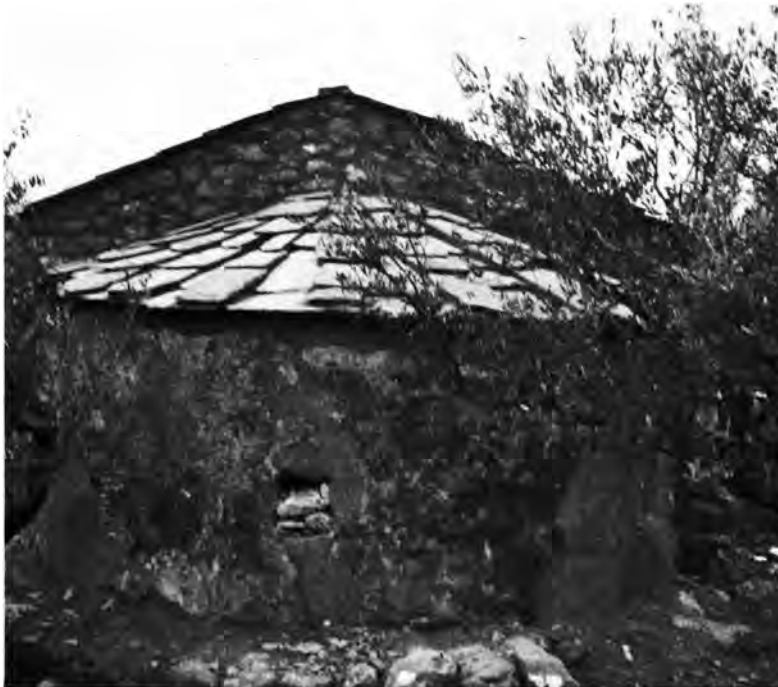
Μάνη. Πύργος Διροῦ : α - β. Ναῖσκος Θεοτόκου. Ἡ κόγχη τοῦ ἱεροῦ πρὸ καὶ μετὰ τὰς ἐργασίας
