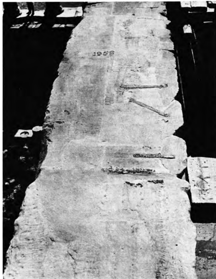
Ἀθήναι : α - β. Ἡ ἄνω ἐπιφάνεια τῆς ἐπικρανίτιδος τῆς Ν. πλευρᾶς τοῦ Ἐρεχθείου πρὸ καὶ μετὰ τὰς ἐργασίας συντηρήσεως
