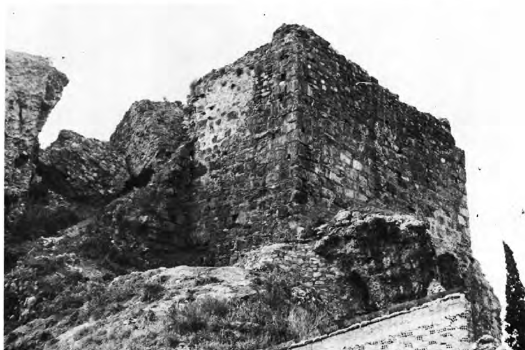
Κάστρον Καλαμάτας : α - β. Ὁ Β. πύργος πρὸ καὶ μετὰ τὰς ἐργασίας
