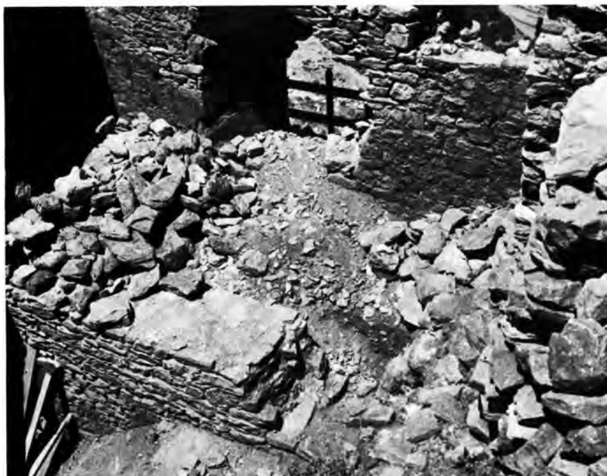
Κάρυστος. Καστέλλο - Ρόσσο : α. Ὁ Δ. τοίχος ἀπὸ Ν., β. Τὸ ἐσωτερικὸν τοῦ Δ. πύργου πρὸ τῶν ἐργασιῶν
