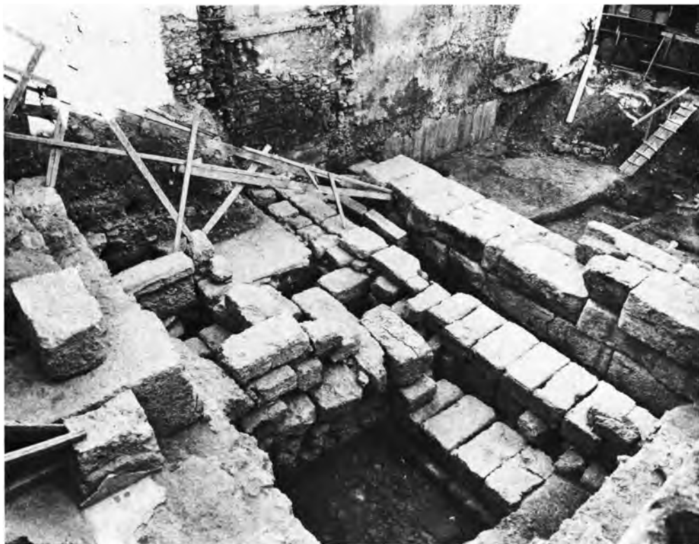
Ἄθῆναι. Οἰκόπ. Ψαρίδη ( ὁδὸς Ἄδριανοῦ 78 ) : α. Θεμελίωσις τῶν τοίχων τοῦ Πανθέου, β. Τοῖχοι παλαιότερων κτηρίων εἰς τὸ ἐσωτερικὸν τοῦ Πανθέου
