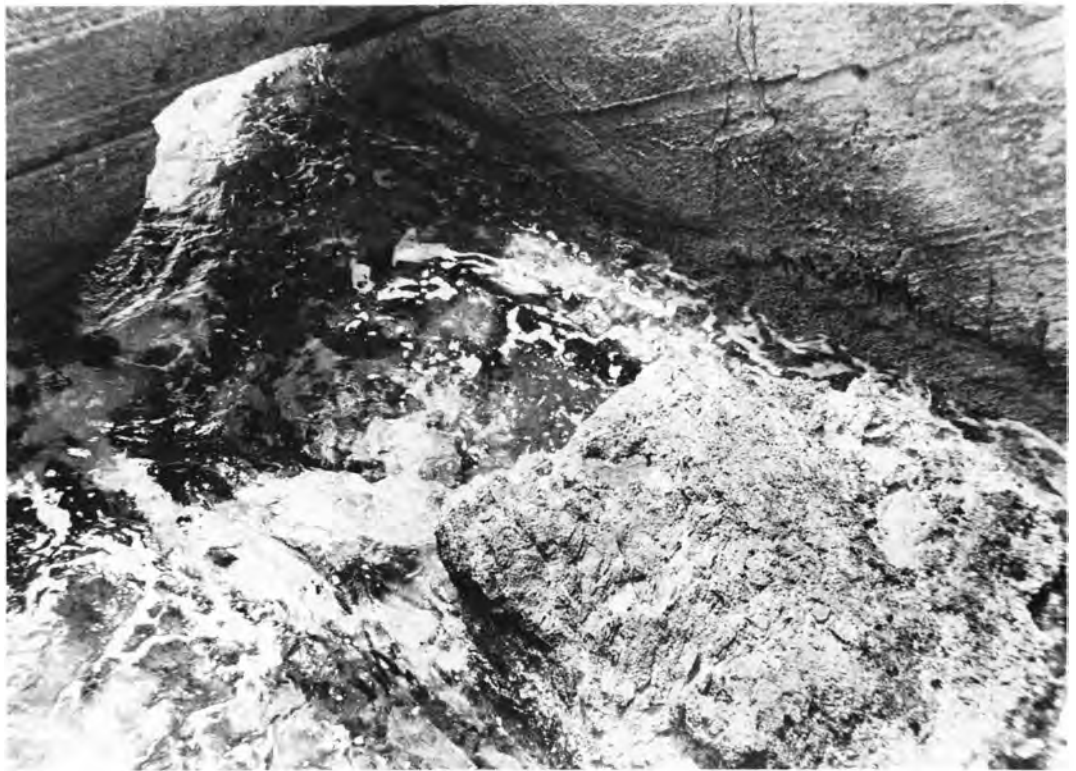
Φέρμα Ίεραπέτρας: α. Ἡ ΝΔ. γωνία τῆς δεξαμενῆς, β. Ὁ πεσμένος βράχος στο Δ. διαμέρισμα ἀπὸ ΒΑ. Κ. ΔΑΒΑΡΑΣ
