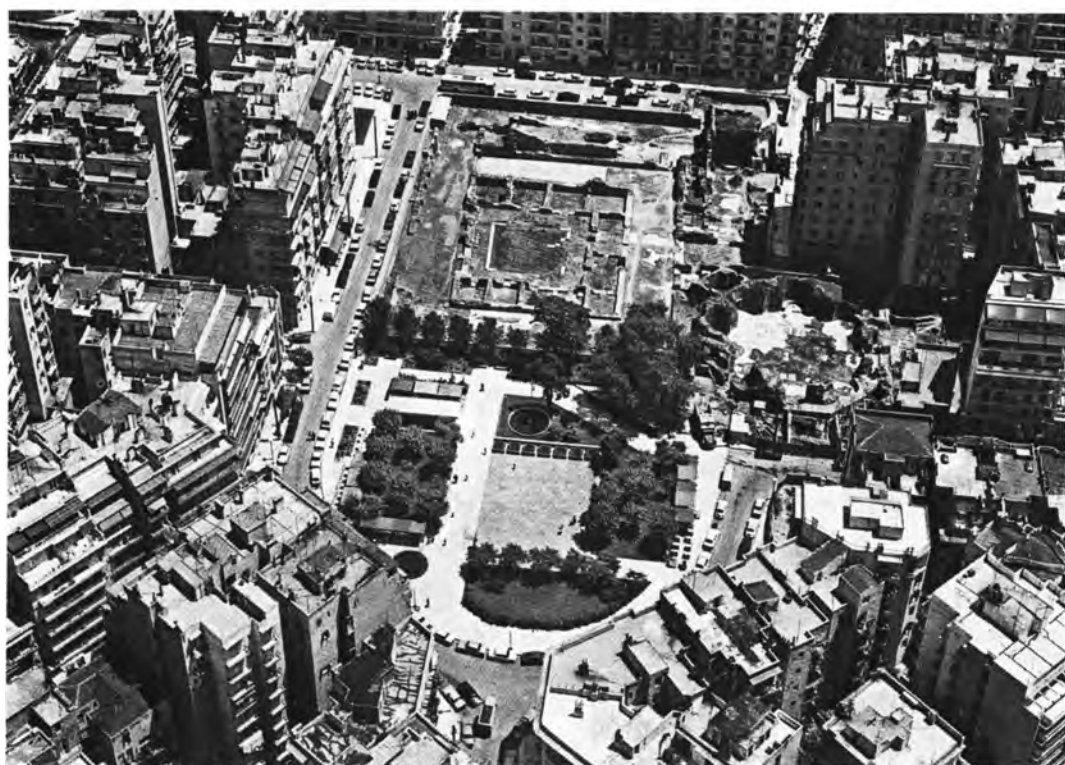
Θεσσαλονίκη. Ὀκτάγωνο: α. ἀνατολικὸ κλιμακοστάσιο, β. δυτικὸ κλιμακοστάσιο, γ. Γενικὴ ἄποψη τοῦ διασωθέντος τμήματος τοῦ ἀνακτορικοῦ συγκροτήματος
