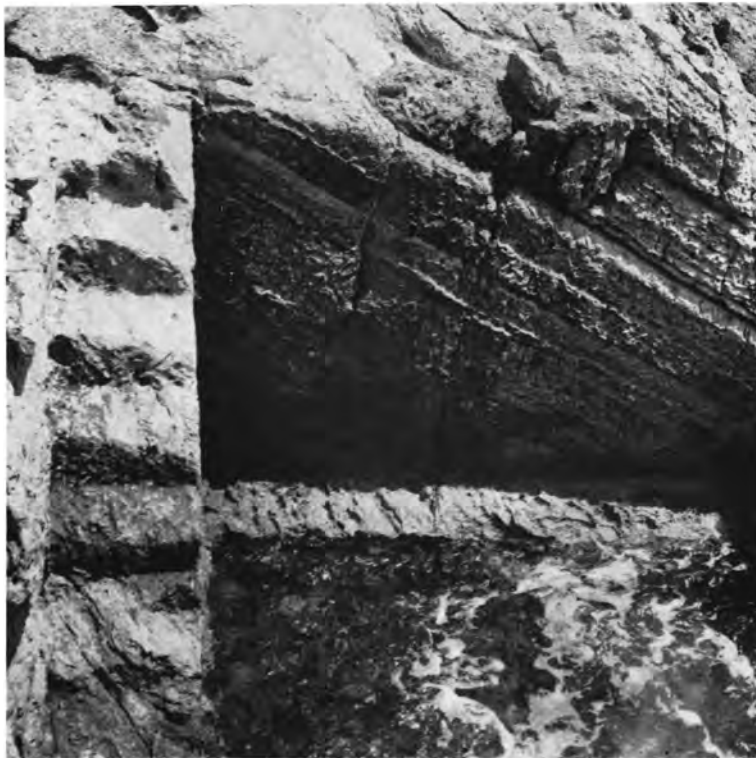
Φέρμα Ίεραπέτρας: α. Ίχθυοδεξαμενή. Α. πλευρά, β. Ίη σκάλα καί τμήμα τής Α. πλευράς Κ. ΔΑΒΑΡΑΣ
