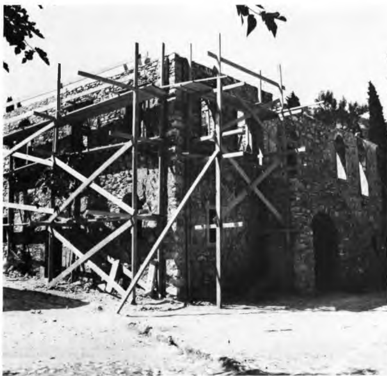
Χίος. Νέα Μονή: α-β) Κελιά της δυτικής πλευράς, πριν και κατά τη διάρκεια των εργασιών.
