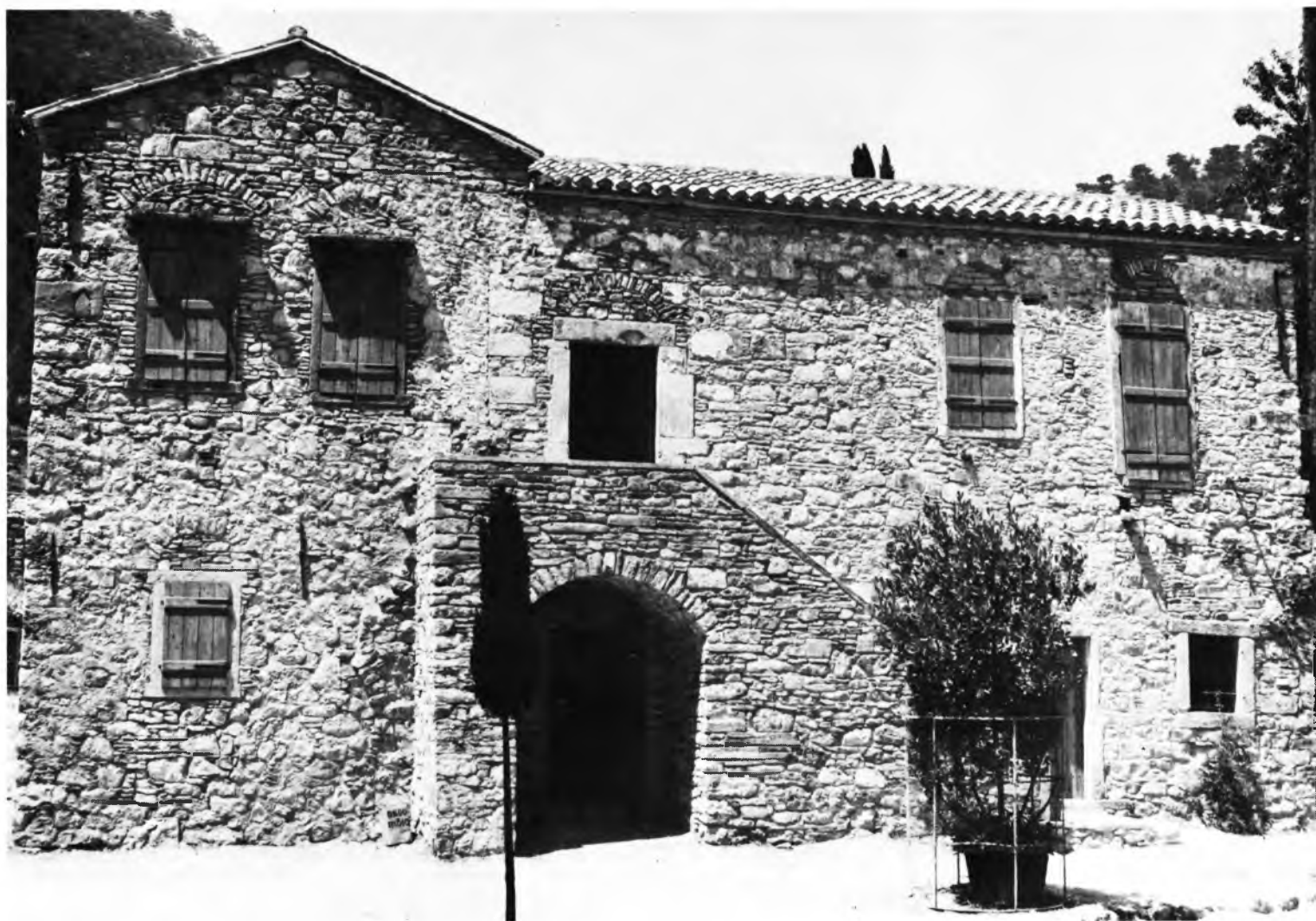
Χίος. Νέα Μονή. Κελιά της δυτικής πλευράς, μετά τις εργασίες.
