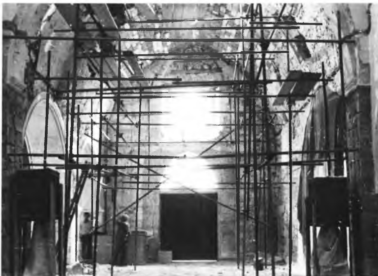
Μουσείο Χανίων: α) Εσωτερικός χώρος Α. Ανατολική πλευρά, κατά τη διάρκεια των εργασιών, β-γ) Χώρος Β, μετά την αφαίρεση των παλιών επιχρισμάτων, και λεπτομέρεια απ' αυτόν.
