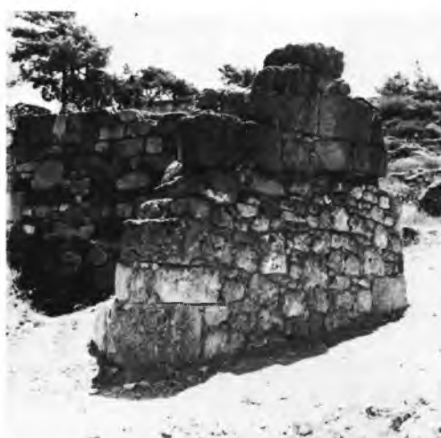
Κάμιρος: α-β) Ο τοίχος 43, πριν και μετά τη στερέωση. γ) Ο τοίχος 42, πριν τη στερέωση, δ-ε) Ο τοίχος 34, πριν και μετά τη στερέωση.
