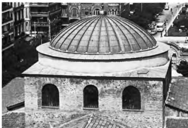
Θεσσαλονίκη: α) Οδός Επαμεινώνδα 10. Κόγχη παρεκκλησίου στον πύργο του βορειοδυτικού τείχους, β) Αγία Σοφία. Καθαρισμός στο εξωτερικό μέρος της βάσης του τρούλου, γ-δ) Αγία Σοφία. Πλακόστρωση της βάσης του τρούλου και ο τρούλος του ναού, μετά τις εργασίες.
