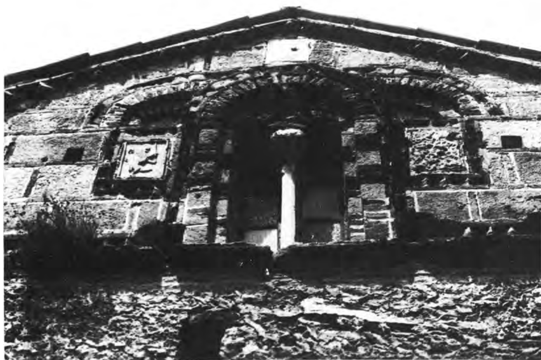
α) Λευκόχωμα. Άγιος Νικόλαος. Τύμπανο νότιας κεραίας του σταυρού, β) Μυστράς, Περίβλεπτος. Νότια πλευρά (λεπτομέρεια).
