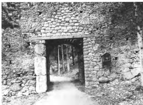
α) Ναύπακτος. Τζαμί του Λιμανιού. Η βάση του μιναρέ, μετά τις εργασίες, β-γ) Βόνιτσα. Φρούριο. Η βυζαντινή πύλη της νότιας πλευράς, πριν και μετά τις εργασίες.
