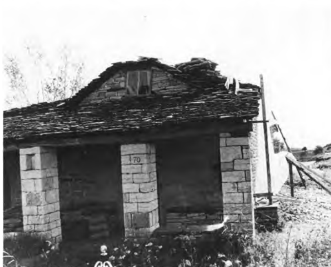
α-β) Ιωάννινα. Οικία Χουσεΐν Μπέη, πριν και κατά τη διάρκεια των εργασιών, γ) Καπέσοβο Ζαγορίου. Ο ναός Κοίμησης της Θεοτόκου, κατά τη διάρκεια των εργασιών.
