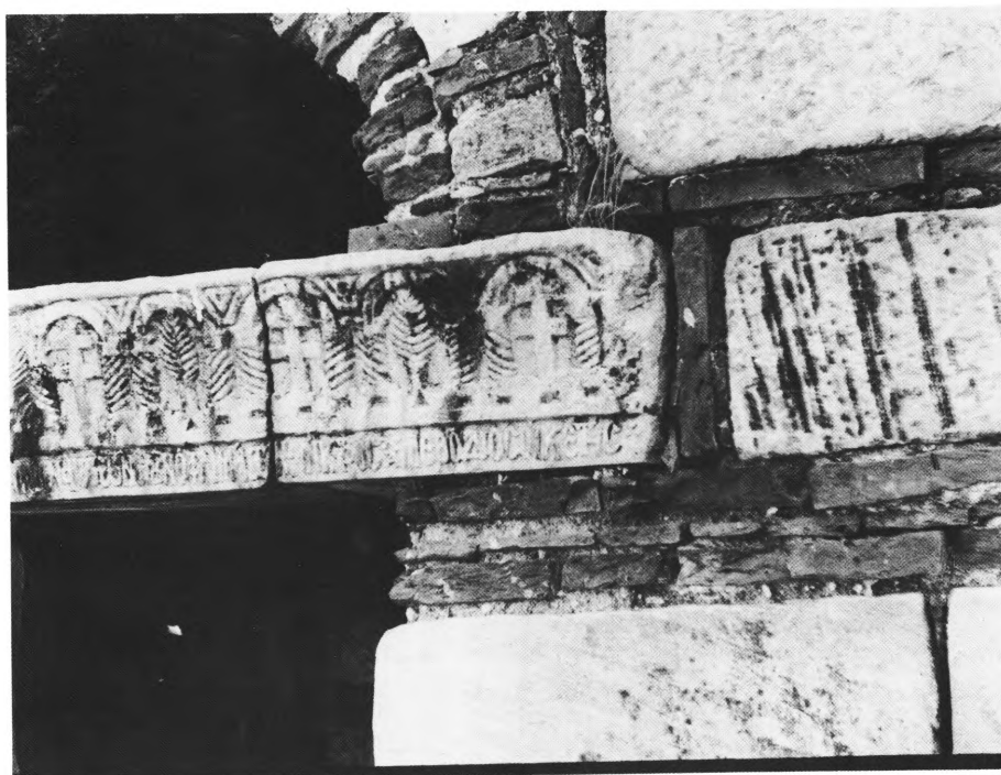
a) Kahne Assar Adasi, east façade, b) Ikis Ada, west façade.
